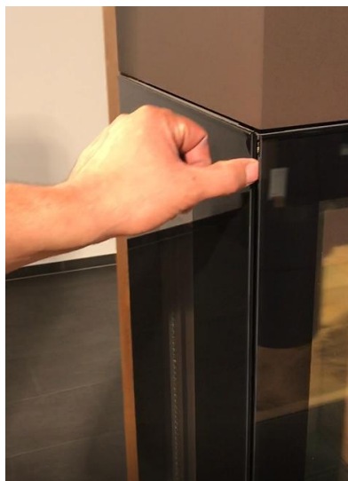
4. 左側のガラス面が開きます。開かない場合は、2. のボルトをもう少しゆるめます
