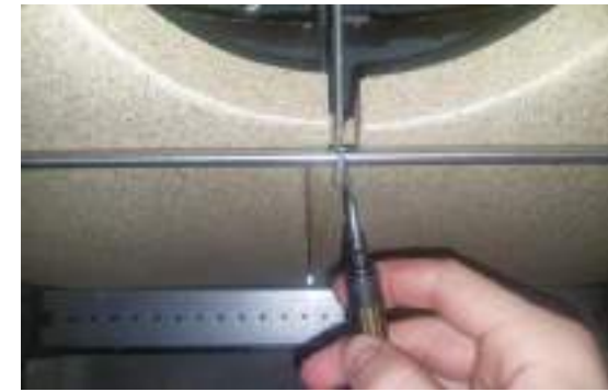
③ブラケットを動かさず、バーに印を付ける（ブラケット右側）
