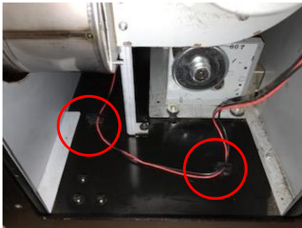
点検窓から 2 箇所
